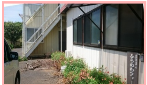
研修施設兼発送センター を開設するため改修工事を行っています。今年度末をめどにオープン 場所 千葉県八街市
